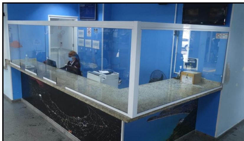
Figura 20 - Instalação de proteção
