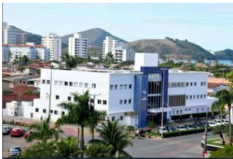
Figura 11 - Unidade Pronto Atendimento Central
